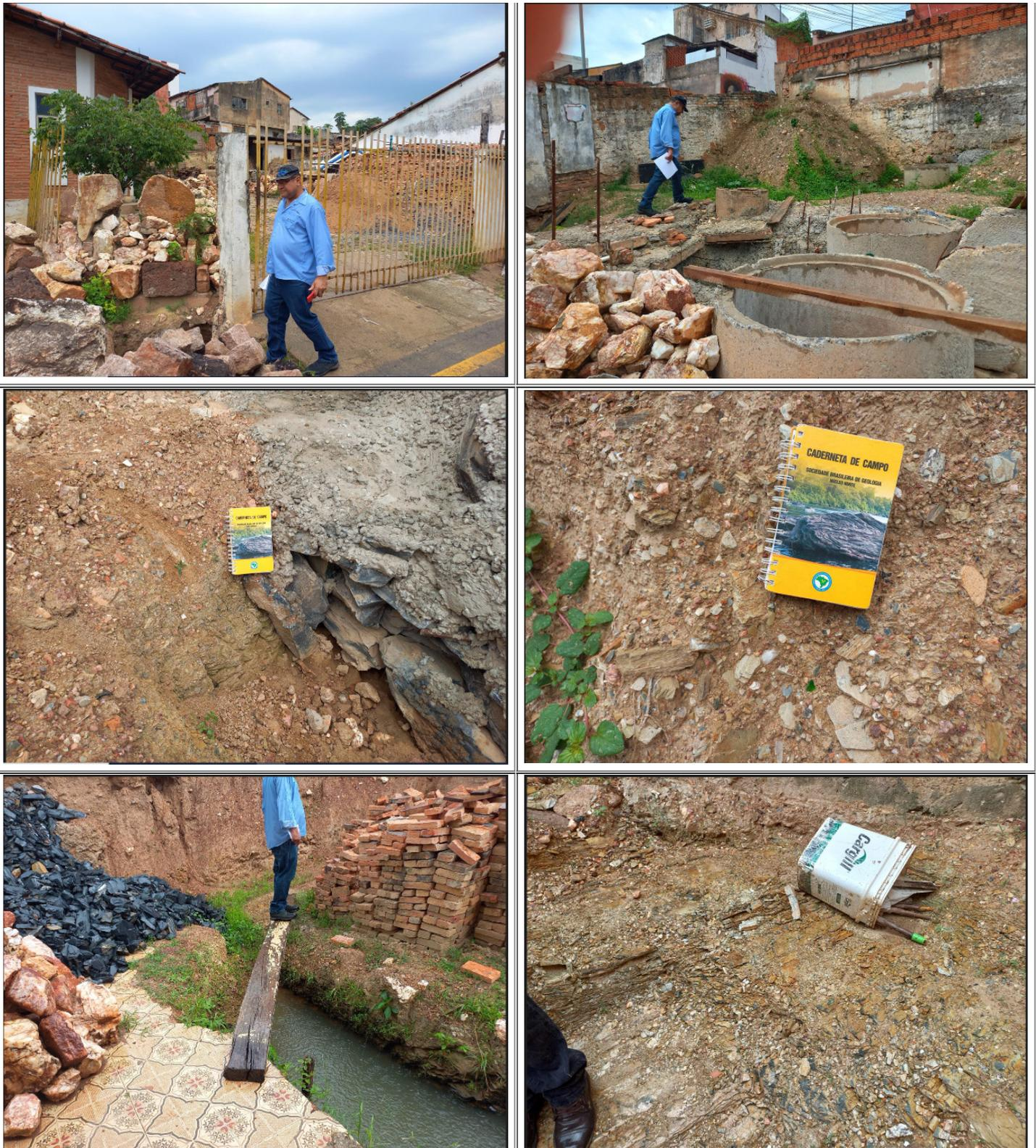
**Fotograma 1** - Registro fotográfico mostrando o material rochoso encontrado no local (rua Ricardo Franco), além de obras de contenção de muro de arrimo, cavas de esgoto, exposições de filitos do Grupo Cuiabá não mineralizado.
